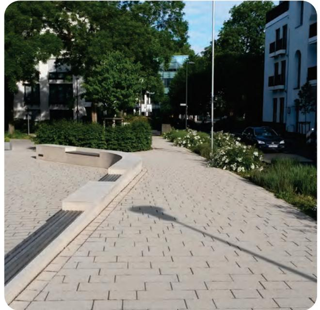
Abb. 20 Geländeoberfläche mit erhöhtem Rückstrahlungsvermögen
