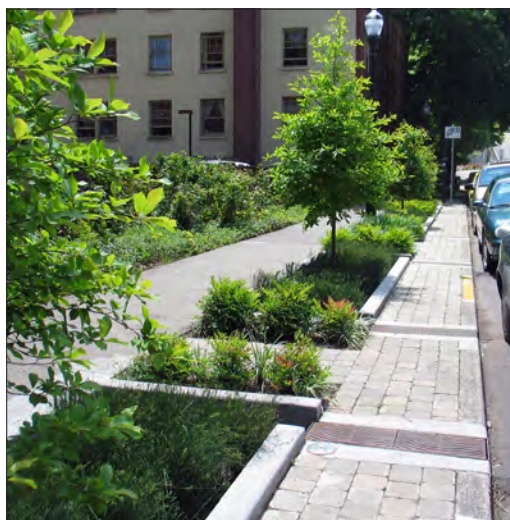
Abb. 3.4 Versickerung über Tiefbeete im Straßenseitenraum [City of Portland]
