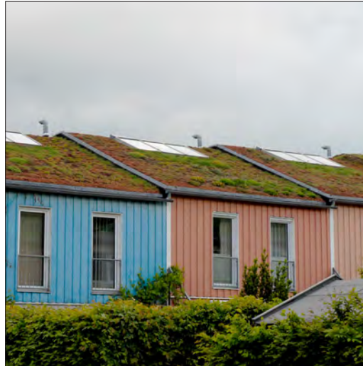
Abb. 3.16 Begrünung von Dächern in einem Wohngebiet in Hannover [MUST Städtebau]
