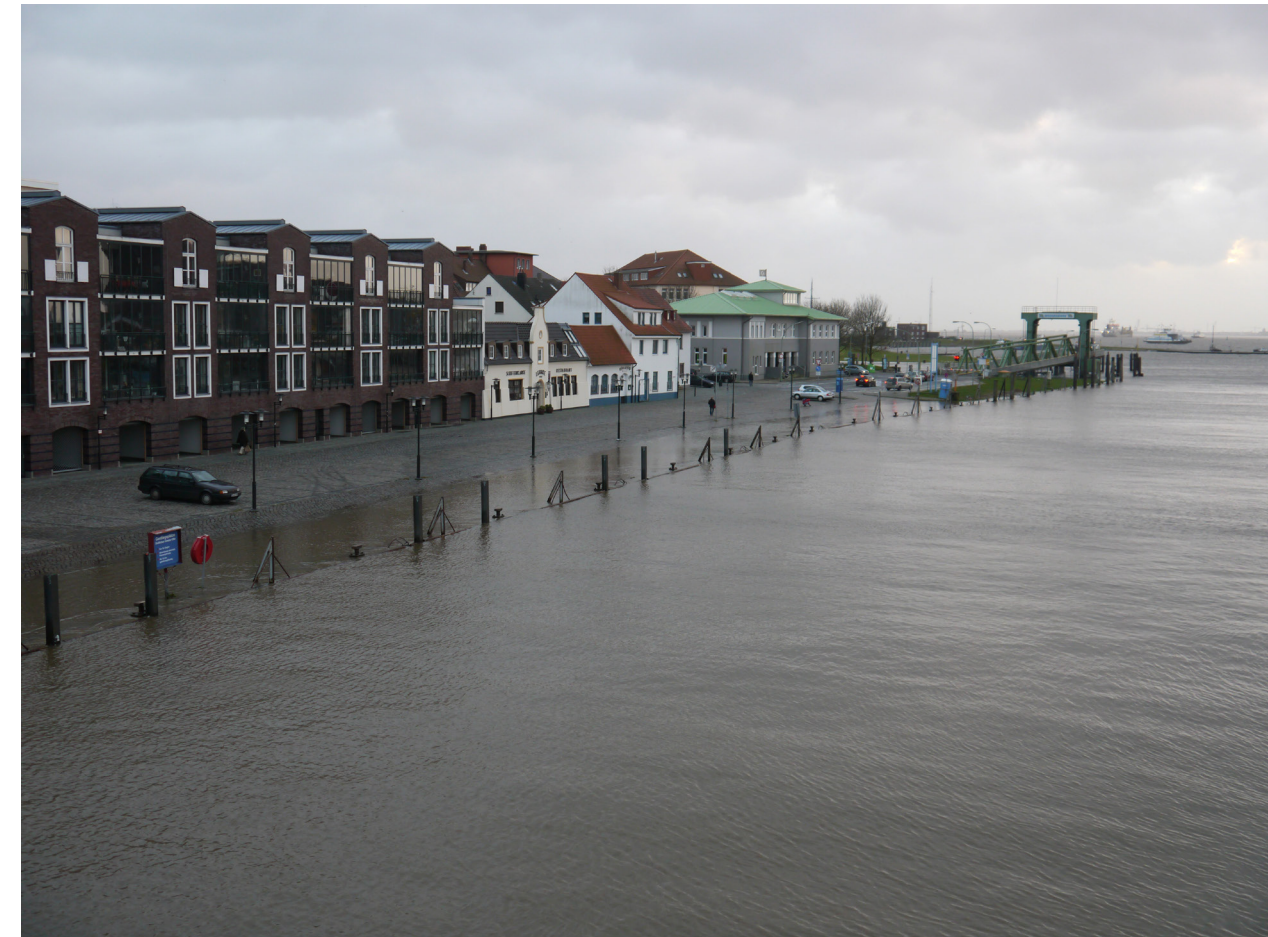
Abb. 08 Schwere Überflutungen können erhebliche Sachschäden verursachen
