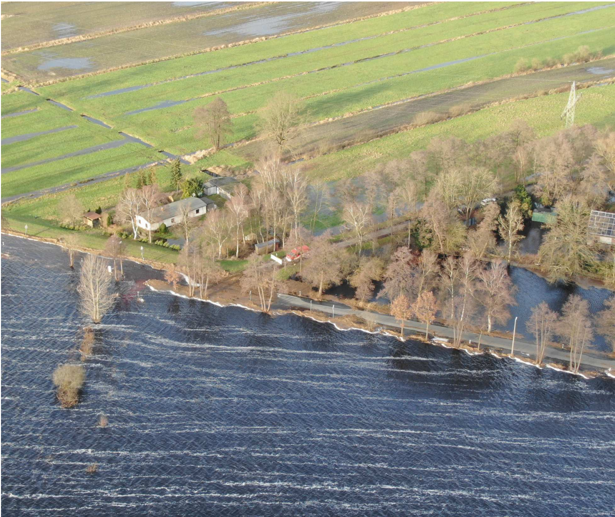
Abb. 14 Im Winter 2023/2024 kam es in Bremen infolge ergiebiger Niederschläge zu einem starken Hochwasser
