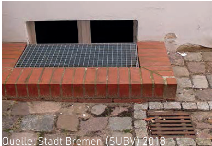
Geschützter Lichtschacht durch Aufkantung
