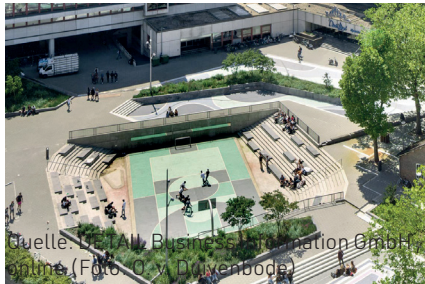
Kombination Regenrückhaltebecken und Amphitheater mit Sportplatz
